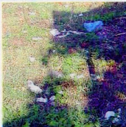
Un fossato della Superstrada per San Marino ridotto a discarica
