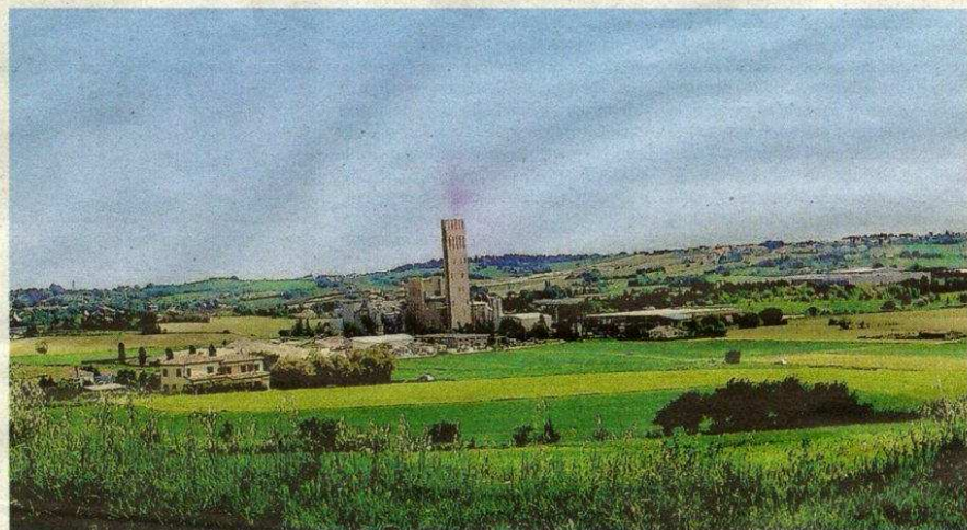
Il camino dell'inceneritore di Raibano di Coriano lo scorso maggio, quando uscì il "fumo rosa" prodotto da iodio in eccesso
